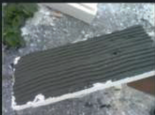
Нанесение клея
